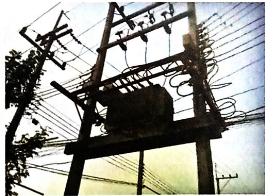
รูปที่ 7.3 การติดตั้งหม้อแปลงบนนั่งร้านคอนกรีต
