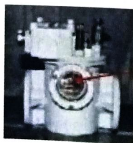
รูปที่ 7.16 การตรวจสอบบุชโฮลรีเลย์ (Buchholz Relay) (ถ้ามี)
