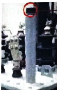
รูปที่ 7.15 การตรวจสอบอุปกรณ์ความดัน (Pressure Relief Device) (ถ้ามี)
